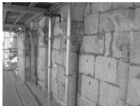
Abb. 2.: Einheitliches Mauerwerk aus großformatigen Kalksteinquadern
